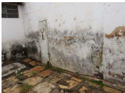
Figura 5. muro com diversos pontos de vesículas.
